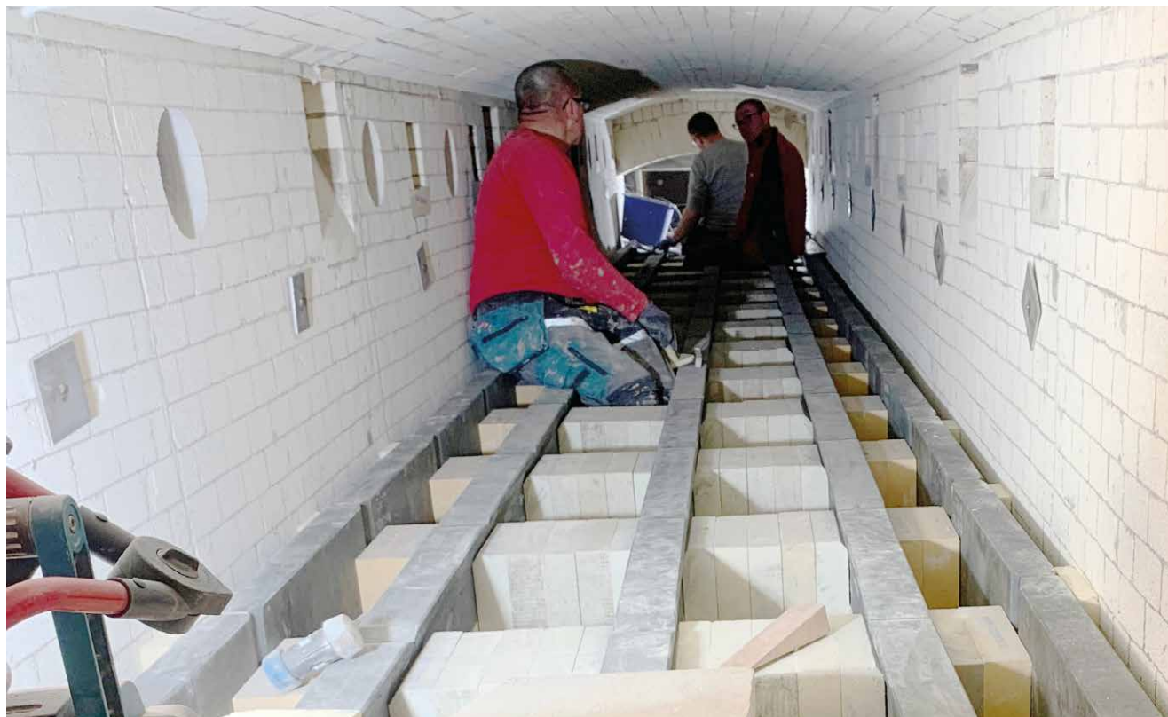
Arbeiter beim Erstellen der neuen Ausmauerung im Ofen.
